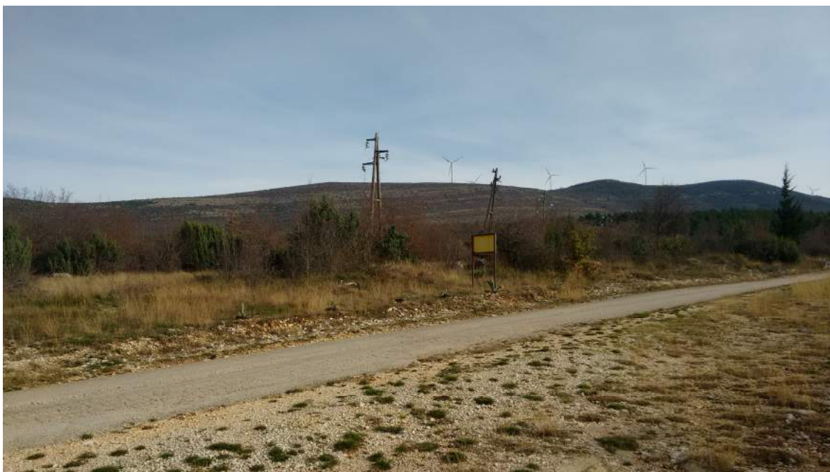
Pogled na postojeću prometnicu LC 63206 prema istoku
